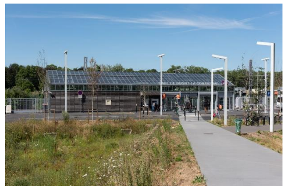
La gare Dugny – La Courneuve T11
